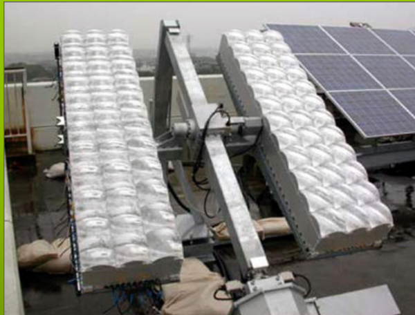
Concentradores solares fotovoltaicos Aumentan la eficiencia al 35%
